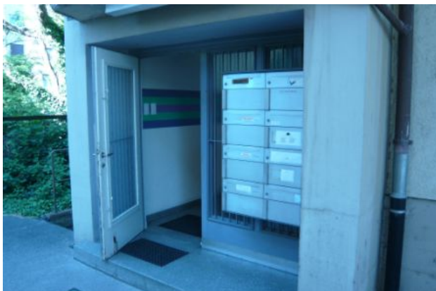
Eingangspartie, Einfachverglasung
