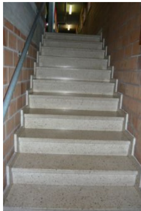
Treppe in Kunststein
