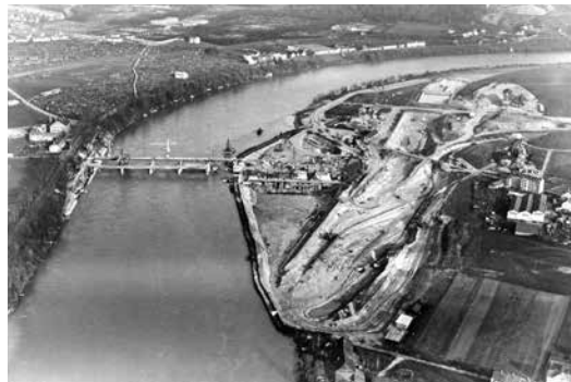
Bau des Birsfelder Hafens.
