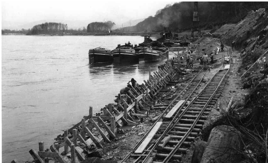
Bau des Birsfelder Hafens.
