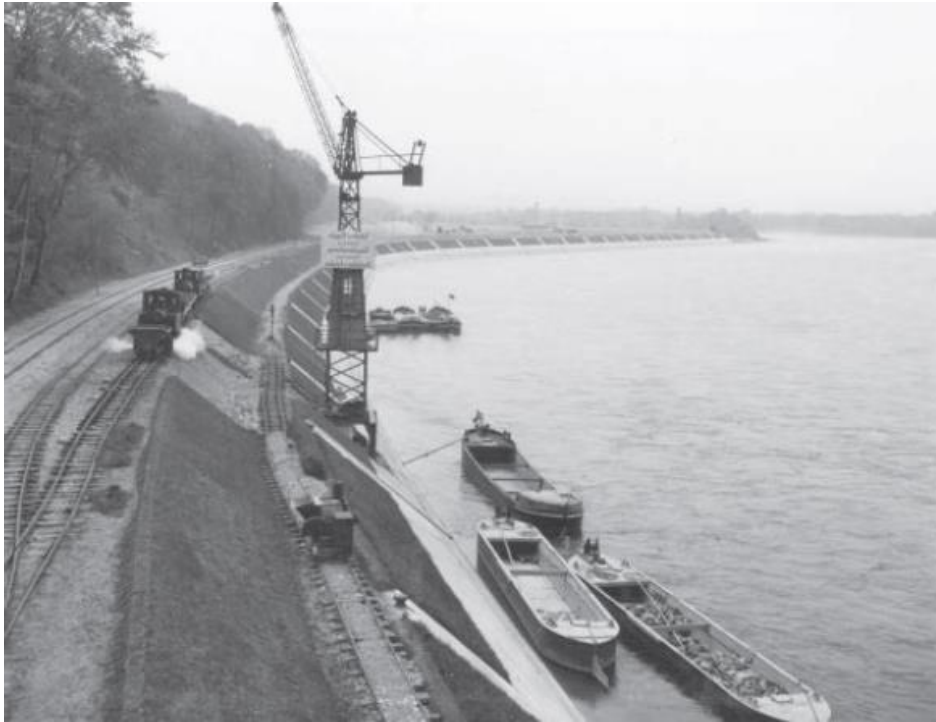
Abbildung 2: Hafenbahnhof Birsfelden im Bau um 1935
