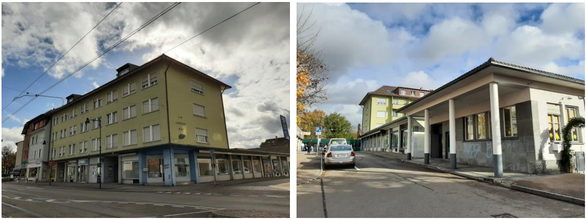
Abbildung 2 Bebauung im Bestand 1 x von Hauptstrasse aus, 1 x von Birsstegweg aus (Quelle: Stierli + Ruggli)
